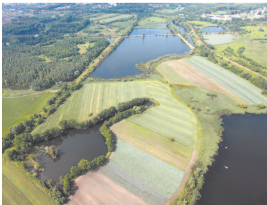
Prace na terenie Żabich Dołów mają rozpocząć się po podpisaniu umowy o dofinansowanie, na początku 2018 roku.
