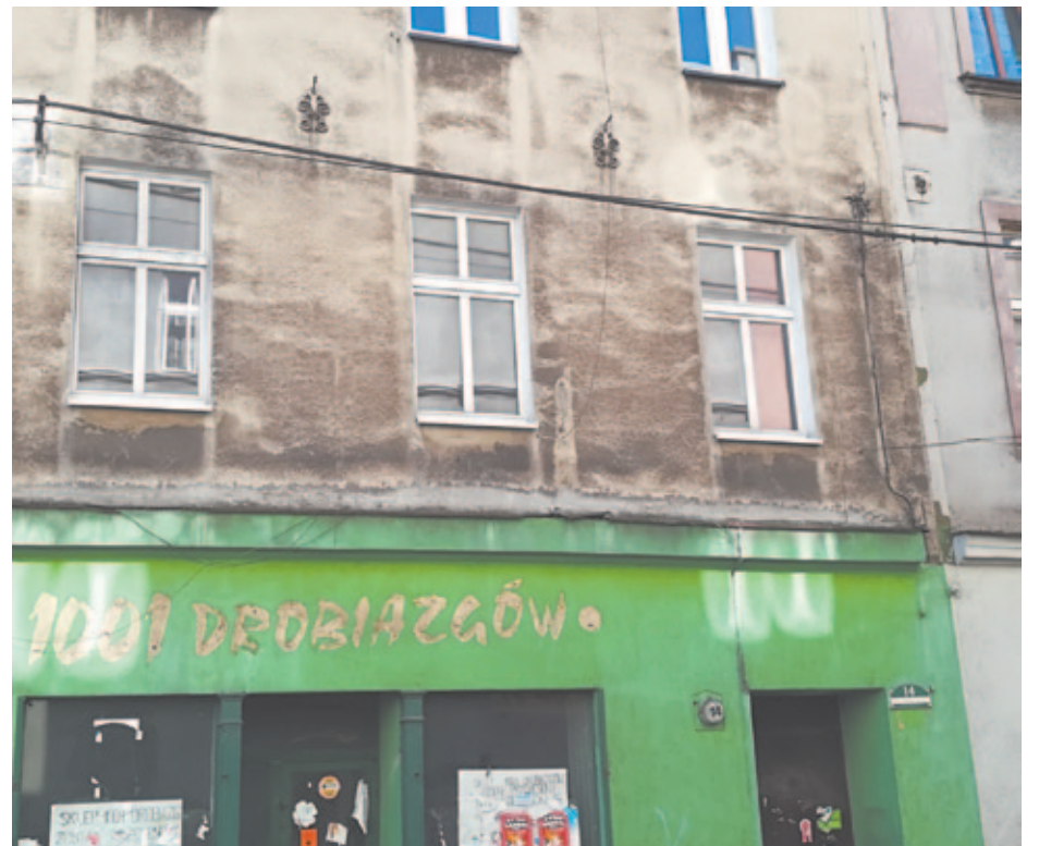
Ten budynek czeka gruntowny remont. Swoje mieszkania i opiekę znajdują tu wytypowani do projektu podopieczni Domu Pomocy Społecznej.
